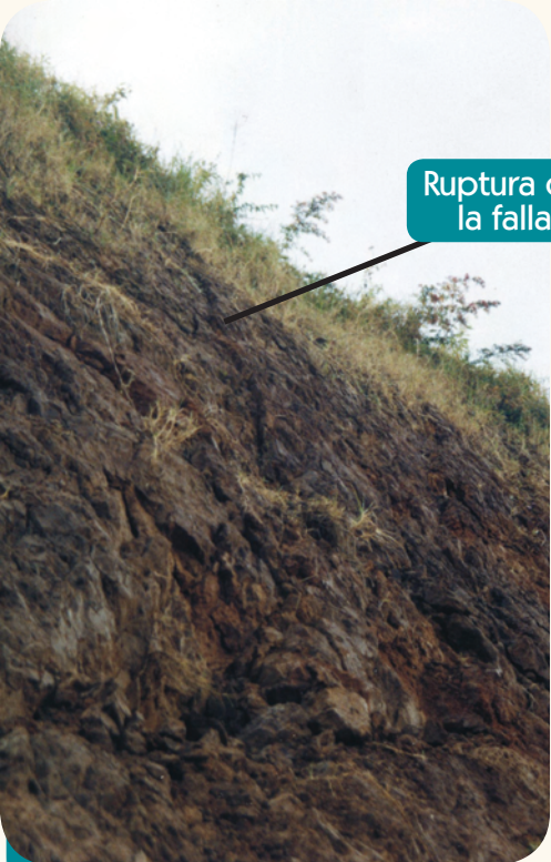
Detalle de la ruptura del segmento de falla en el sector de Montaña Azul (foto Geovanni Peraldo).
