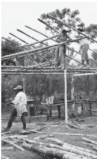
Con árboles que ellas mismas cortaron, mujeres de Nueva Esperanza de Caño Negro construyeron su propio invernadero. La UCR aportó la pintura antitermitas y la malla antivírus.
