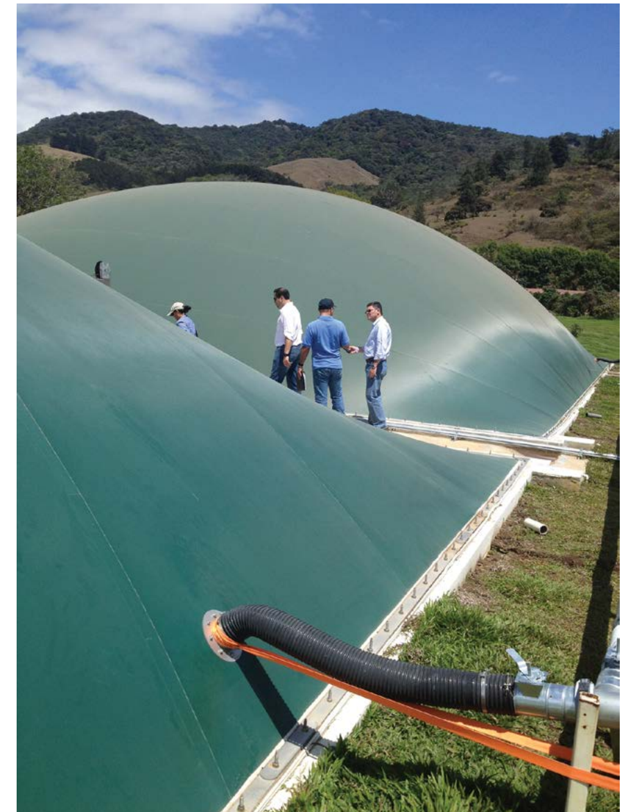
La planta de Porcina Americana cuenta con uno de los biodigestores instalados más grandes del país. (foto Carlos Saborío).
