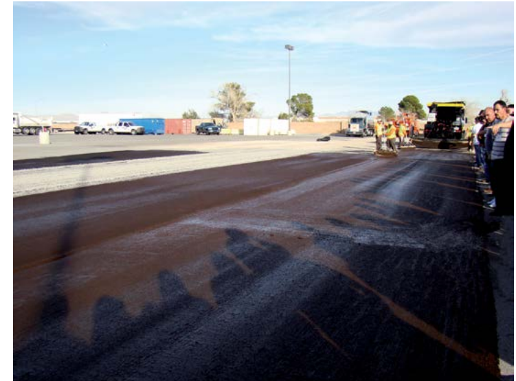
LanammeUCR se encargará de generar las especificaciones con base en experiencias internacionales, para luego adaptarlas a las características nacionales (foto cortesía LanammeUCR).
