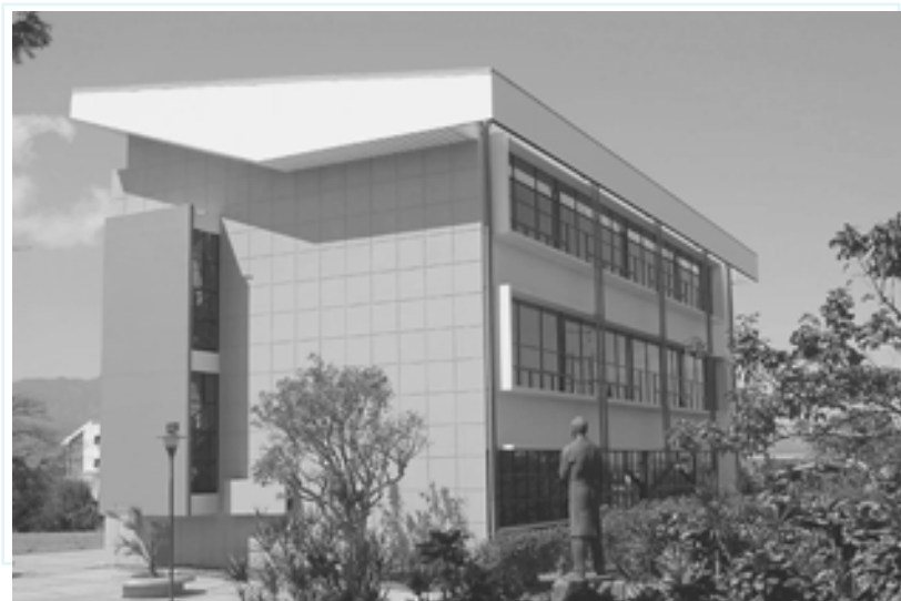
El nuevo edificio consta de un área de 880 metros cuadrados de construcción.
