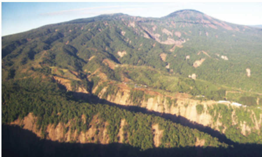
Una de las aplicaciones recientes de la tecnología lidar aérea en Costa Rica fue tras el terremoto de Cinchona en 2009, en la zona afectada por los deslizamientos (foto cortesía RSN).
