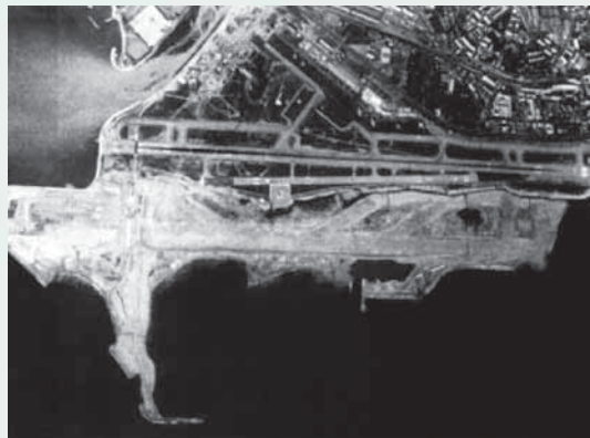
La pista de aterrizaje antes del deslizamiento.
