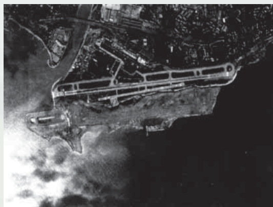
La pista desplazada por el deslizamiento.
