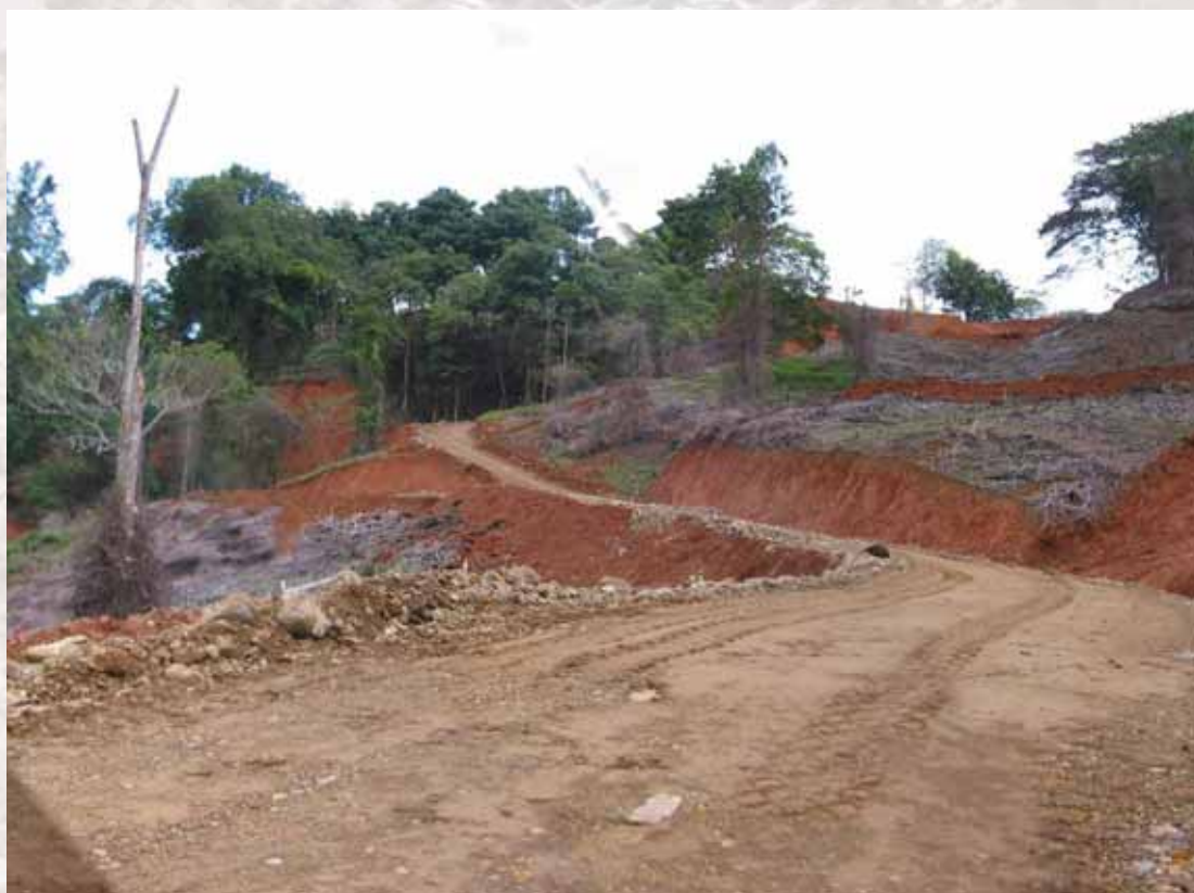
En Punta Uvita hay nuevos proyectos que están en camino, entre ellos condominios de hasta 500 habitaciones.
