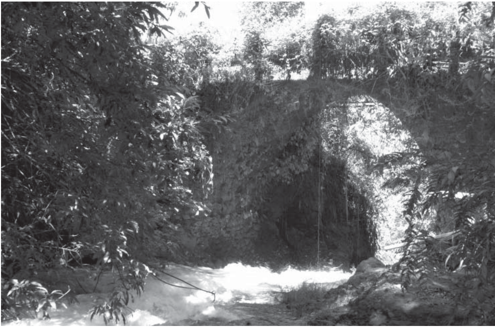
El puente del río Barranca en Piedades Sur fue construido entre 1894 y 1902. (Foto: Dennis Castro Incera)
