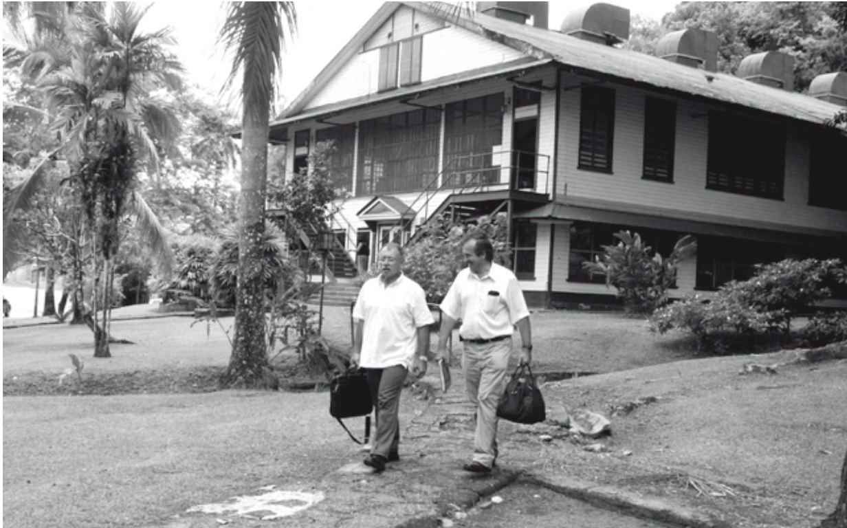
Desde el año 2006, el Recinto Universitario de Golfito fomenta el rescate de patrimonio histórico y la restauración de las edificaciones que poseen un valor arquitectónico en la zona (Foto Alfredo Villalobos J.).
