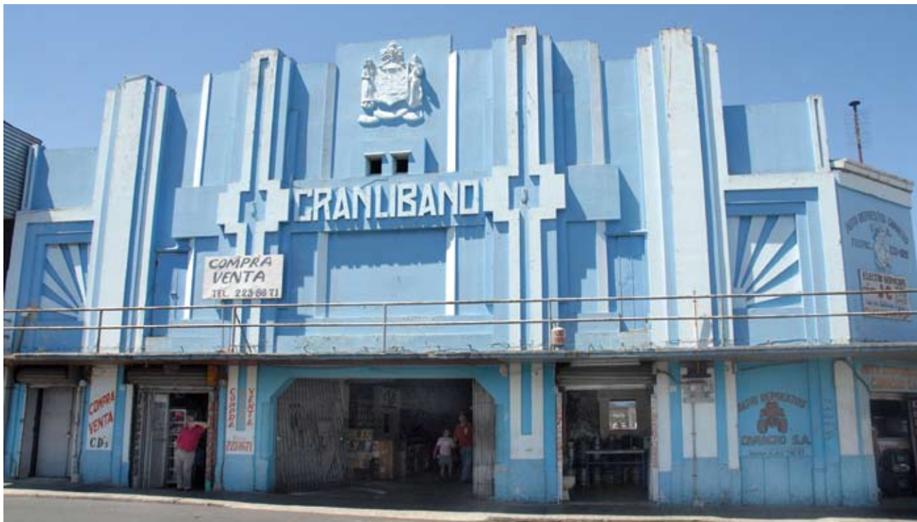
El deterioro del patrimonio histórico-arquitectónico se puede apreciar en el edificio del antiguo cine Gran Líbano.
