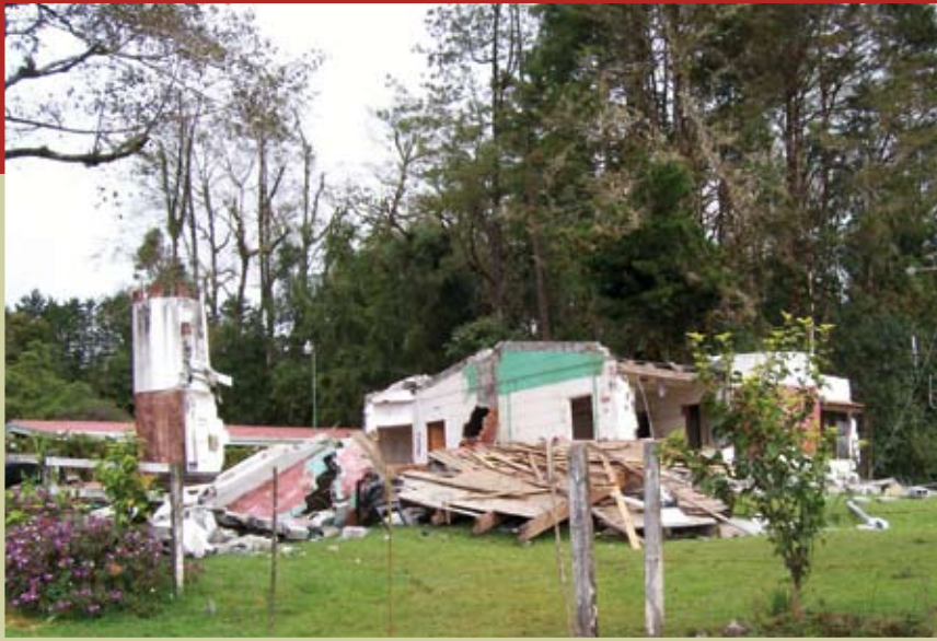
Gran cantidad de casas resultaron totalmente destruidas, como esta en Poasito de Alajuela.
