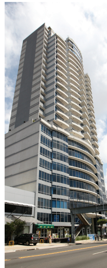
Por iniciativa del LIS, se colocaron cinco acelerógrafos en Torres del Paseo Colón, lo que permitirá monitorear su comportamiento ante los sismos (foto Rafael León).
